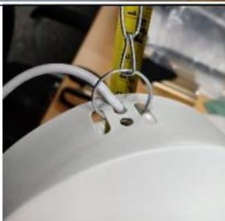
7. Une fois que les 4 chaînes suspendues sont solidement vissées dans la lampe ronde, vérifiez que l'autre extrémité des chaînes est bien fixée à la corniche métallique. Les chaînes métalliques sont reliées entre elles, ce qui permet d'ajuster la longueur/hauteur de la lampe suspendue selon vos préférences. Faites cela avant de fixer la corniche métallique du plafond à la fixation.
